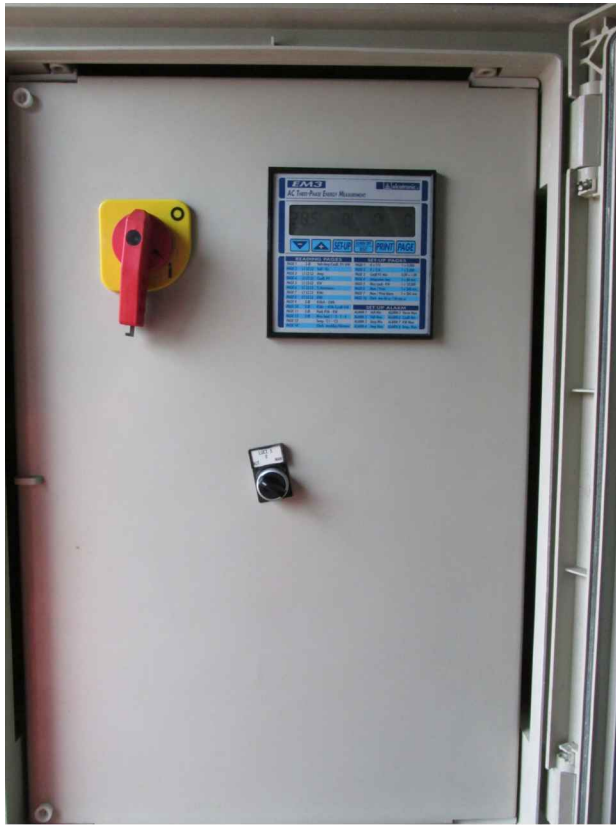
Quadro Q22 - VIA CAPERGNANICA
