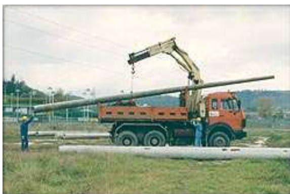
Esempi possibili rischi di contatto linee aeree in tensione
